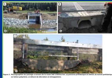
Figure 2. Photographes du passage à tortues de la route 245 à Bolton-Est: a) ponton préfabriqué en béton; b) tunnel préfabriqué en béton précontraint; c) culvres de dérivation et entassement; d) culvres de dérivation et entassement.
